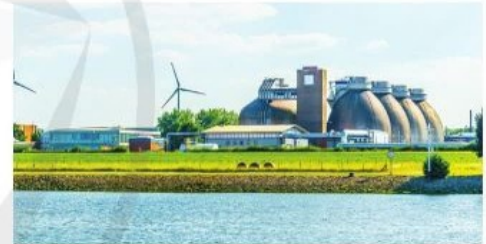
Hình 13.2. Nhà máy sản xuất khí sinh học để phát điện ở Bremen, Đức
