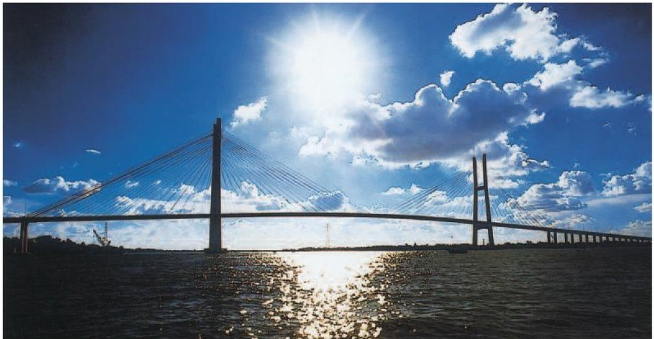
Hình 14.2. Cầu Mỹ Thuận bắc qua sông Tiền
