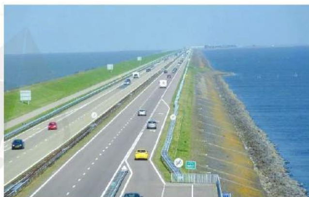
Hình 25.4. Đê Ap-xlui-dic được xây dựng như một chiếc thước kẻ thẳng trên mặt biển giúp cho đất nước Hà Lan có thêm 1 650 km 2 để phát triển các làng mạc và đô thị
